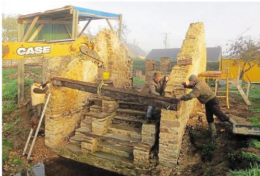
La poutre va trouver son emplacement avec l'aide des bénévoles (Pierrick Dauly au centre) et de la commune.
